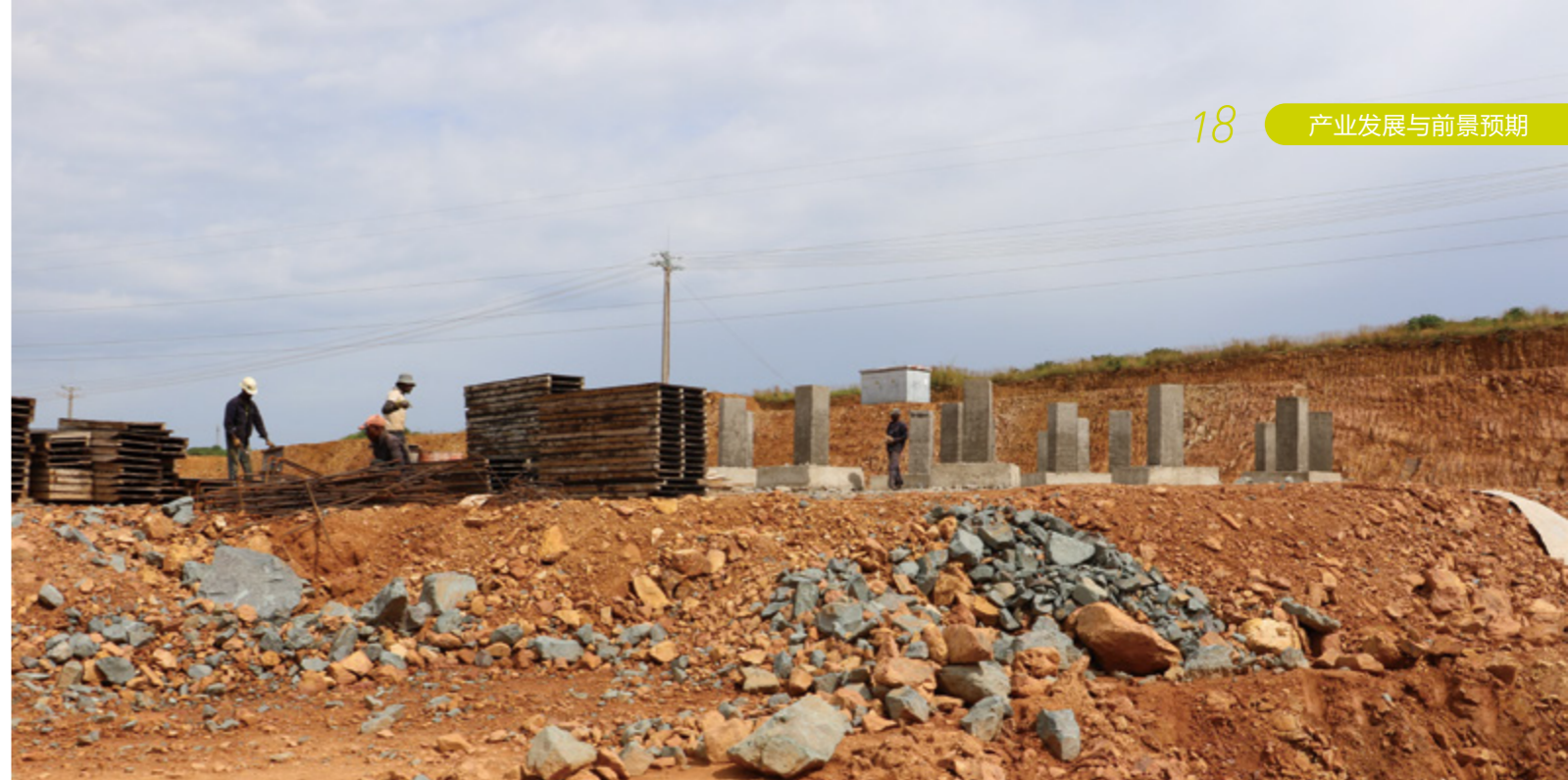
鹏欣资源SMCO钴项目正在紧锣密鼓的建设中 ▲
